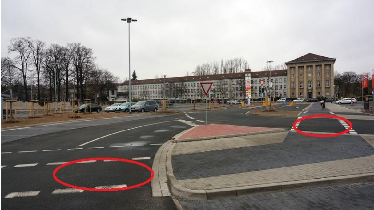
Bild 4: Radwegfurten auf dem Parkplatzgelände - „Vorfahrt gewähren“-Schilder liegen jedoch hinter der Querung - Vorschlag: große Fahrradsymbole mit zwei Richtungspfeilen
