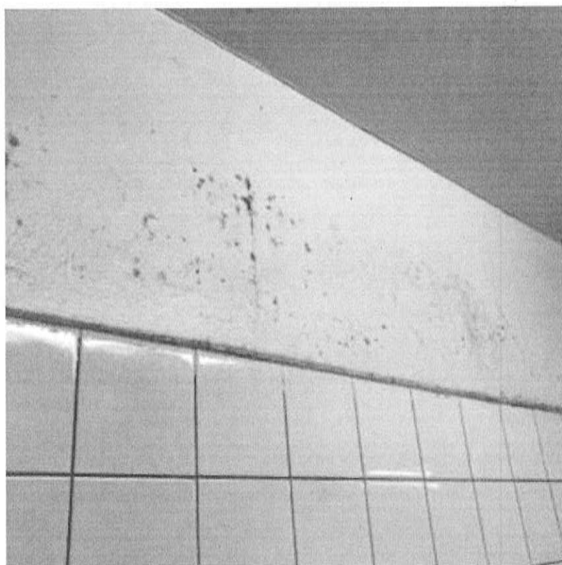
Verschimmelte Wände Duschbereich
