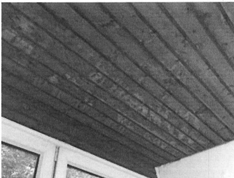
Verschimmelte Decke
