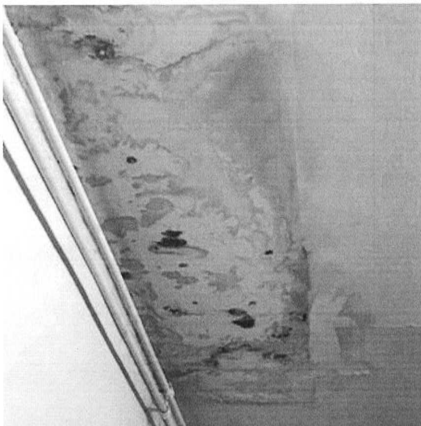
Verschimmelte Decke
