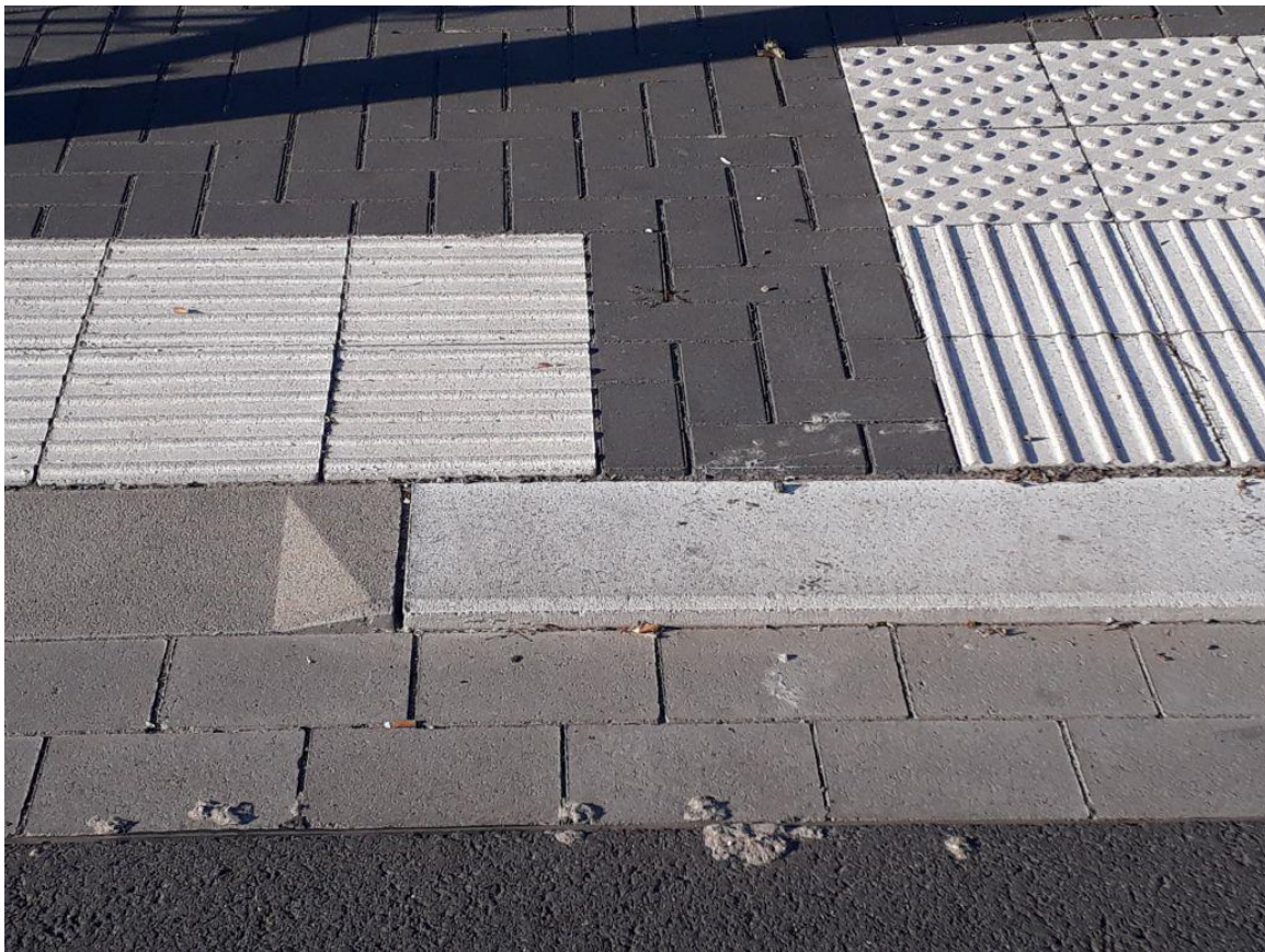
getrennte Querungsstelle mit differenzierter Bordhöhe (Ahaus, NRW)
