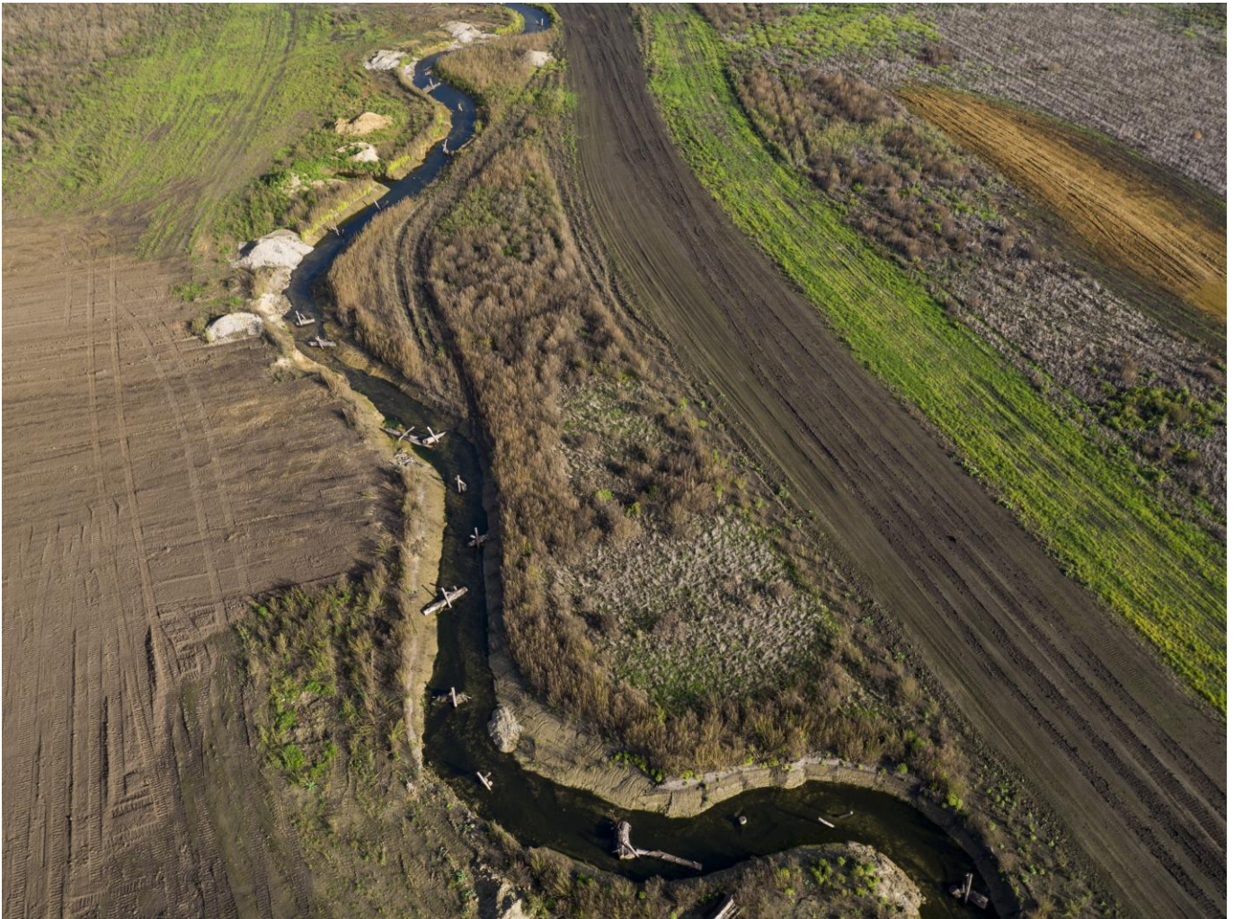
Gewässerlauf mit Strukturelementen
