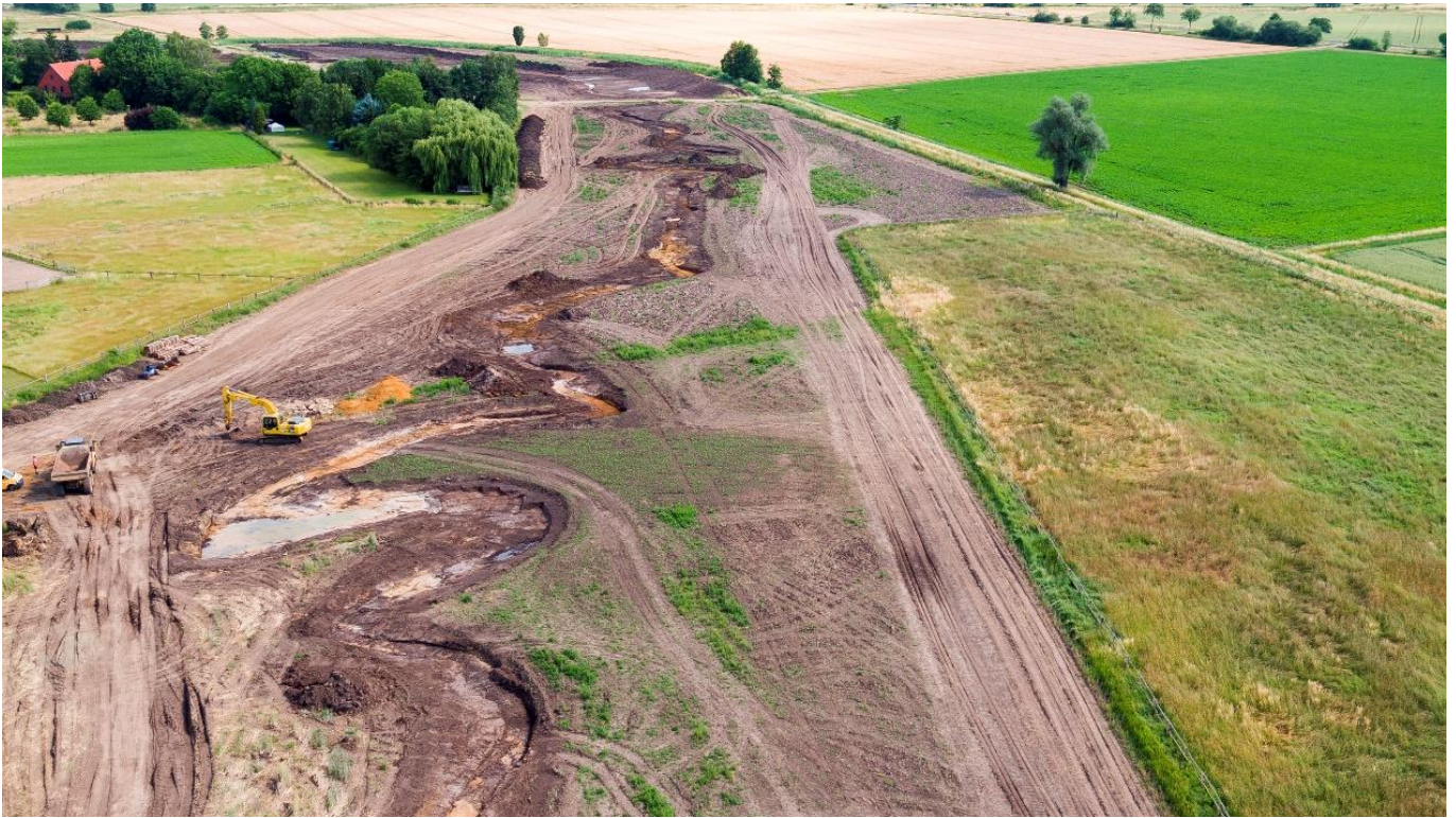
Bauphase Frühsommer 2016, Rautheimer Mühle
