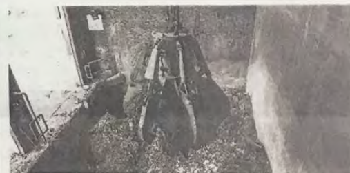
Dieser Tiefbunker ist in der Vergärungsanlage die erste Station des Bioabfalls. Ein Greifer befördert ihn weiter zunächst in die Zerkleinerung.
