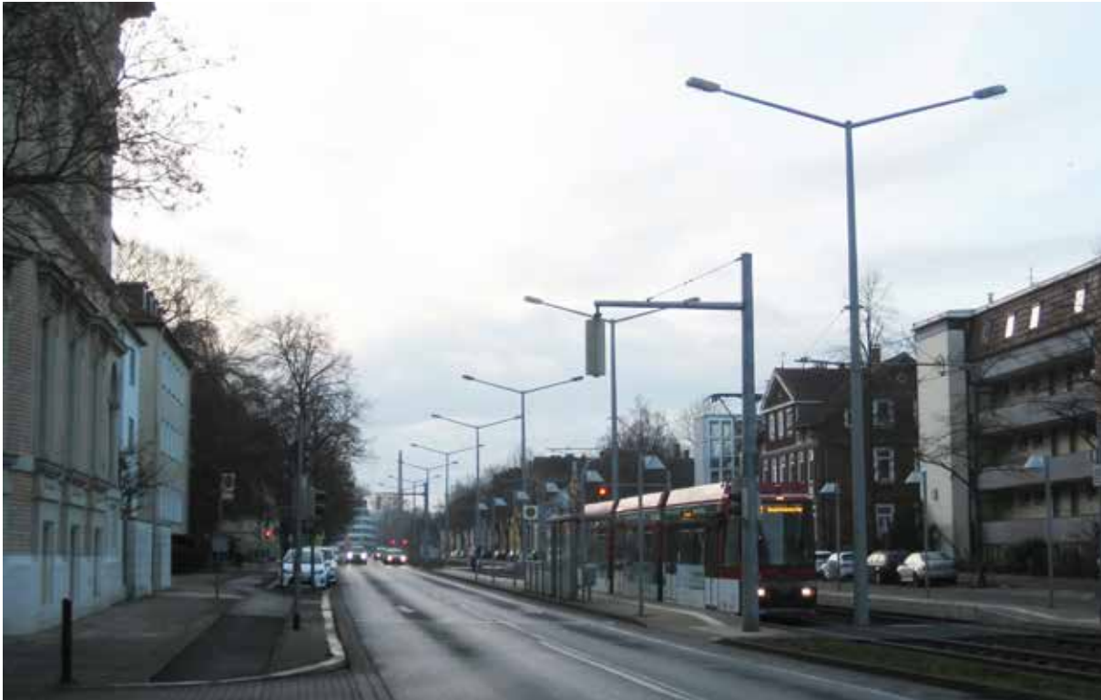
Visualisierung mit mittigen Abspannmasten, die gleichzeitig für die Beleuchtung genutzt werden. Dadurch entsteht eine trennende Wirkung innerhalb des Straßenraums (Beispiel Wolfenbütteler Straße).
