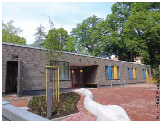
Der Neubau mit barrierefreien Zugang
