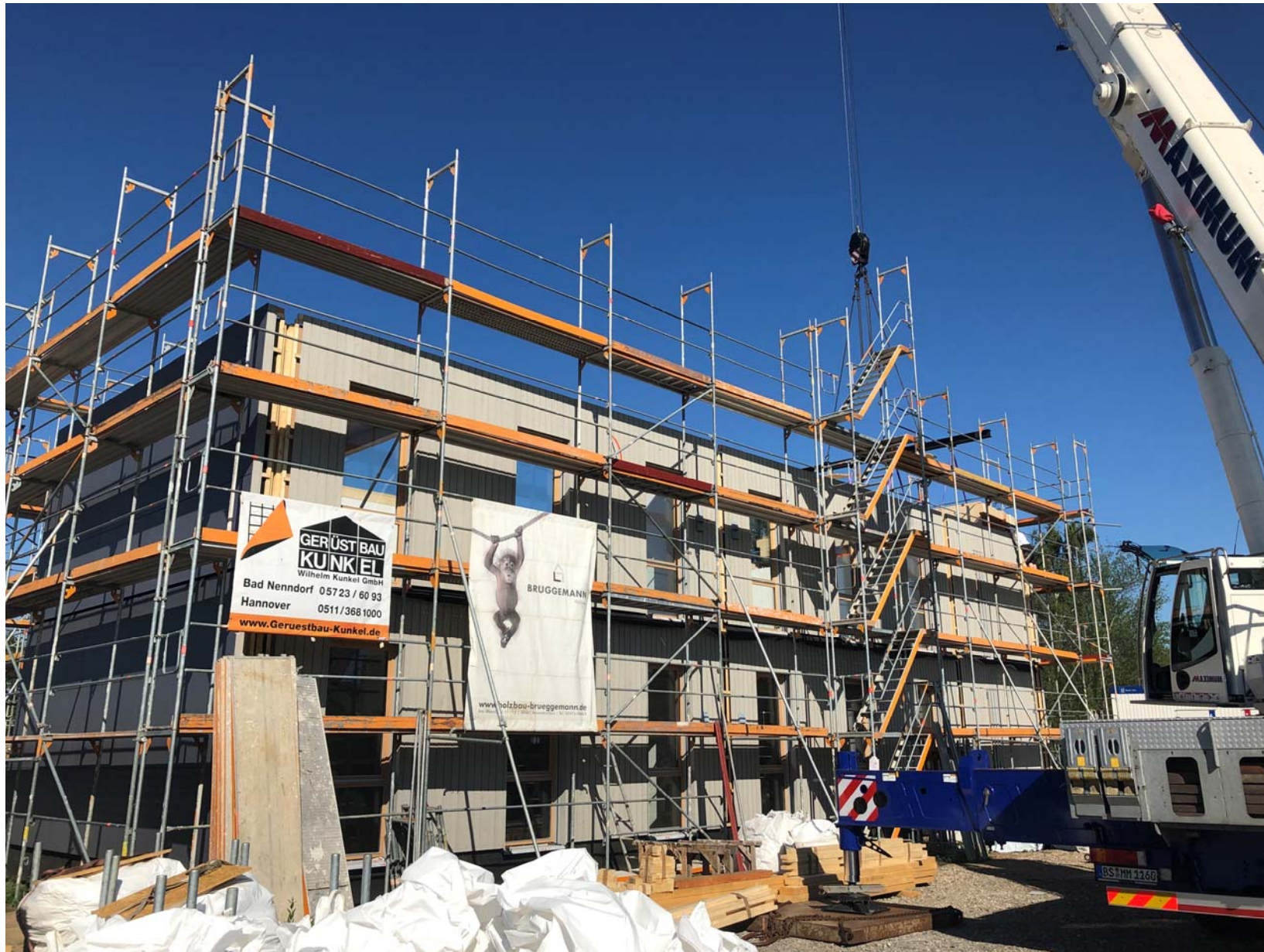
Montage der Holzmodule
