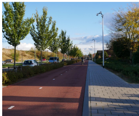
Abbildung 2: Ein Höhenversatz stärkt den Charakter des Radwegs als Fahrbahn, die nicht Teil des Gehwegs ist.
