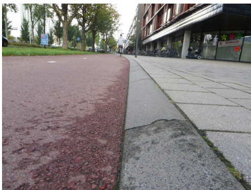
Abbildung 1: Schräge Bordsteine ermöglichen eine deutliche bauliche Trennung von Geh- und Radweg. Die Trennung sollte nicht zu Stürzen führen.
