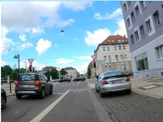
Abbildung 82: vorgezogene Haltlinie an der Leonhardstraße (links) und aufgeweiteter Radaufstellstreifen an der Kälberwiese (rechts)
