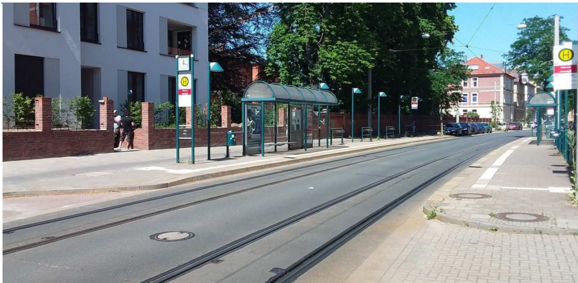
Abbildung 100: Kaphaltestelle Bindestraße für Stadtbahn mit gesonderter Beleuchtung für die Wartefläche
