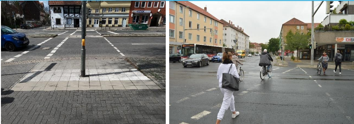
Abbildung 29: Querungsmöglichkeiten mit taktilen Elementen an der Güldenstraße/Südstraße (links) und ohne taktile Elemente an der Güldenstraße/Sonnenstraße
