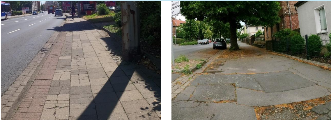
Abbildung 72: Fahrbahnschäden auf der Hildesheimer Straße (links) und Celler Heerstraße in Ölper (rechts)
