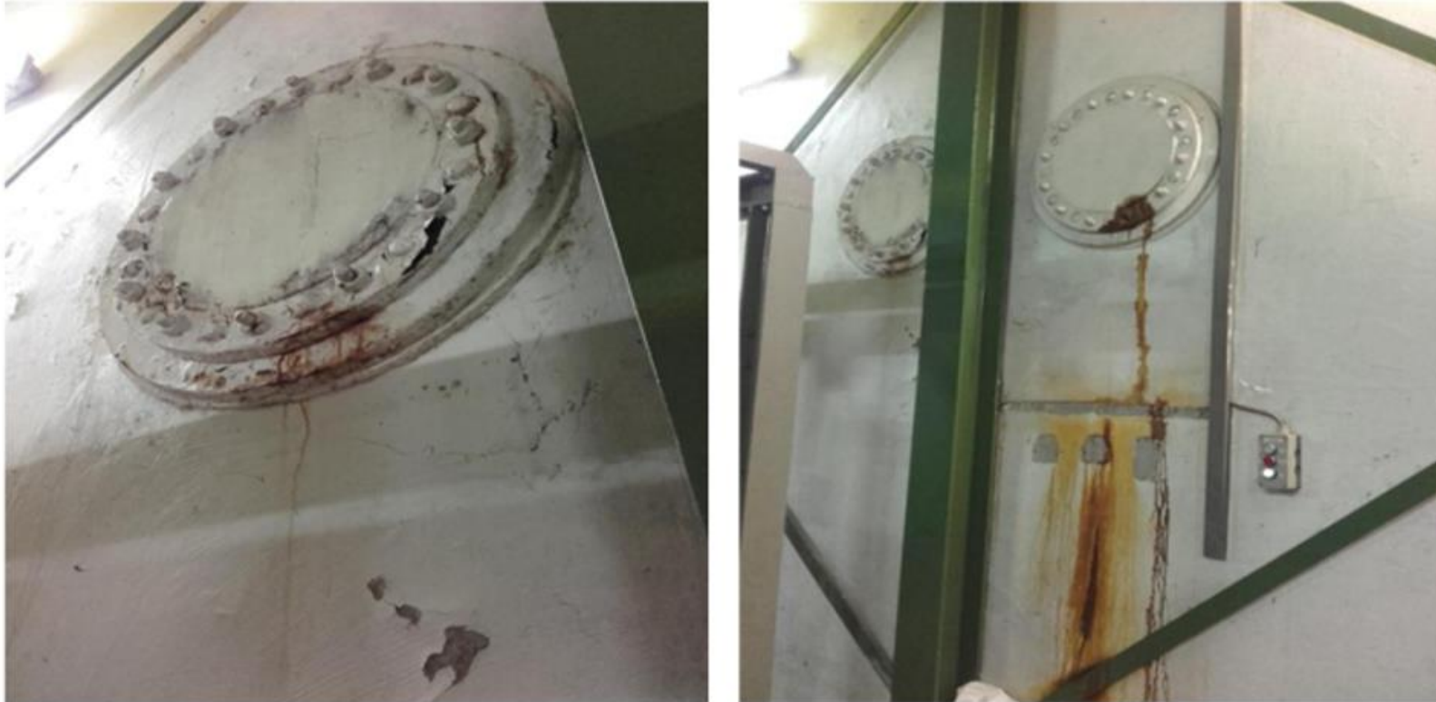
Korrosionsschäden an verschlossenen Rohröffnungen
