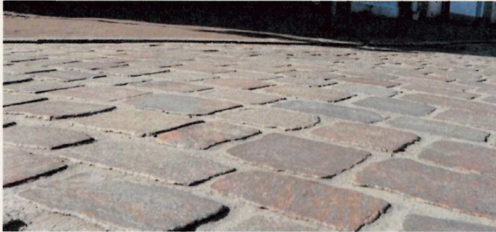
Referenzbeispiel für gesägtes und neu verfugtes Pflaster - Lübeck Fleischhauerstraße
