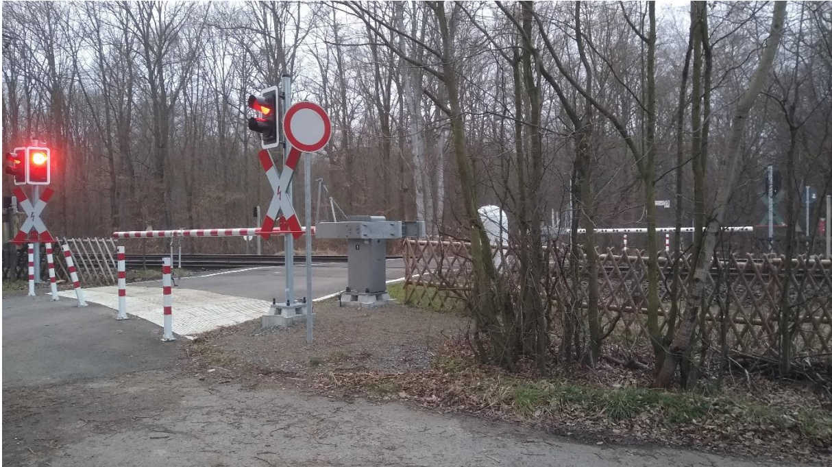
Abbildung 9: Bahnübergang mit ergänzendem Zaun, um Fehlverhalten, wie das Umlaufen des gesperrten Bahnübergangs zu unterbinden; hier Bahnübergang Buchhorst bei Braunschweig (Foto: IfEV)
