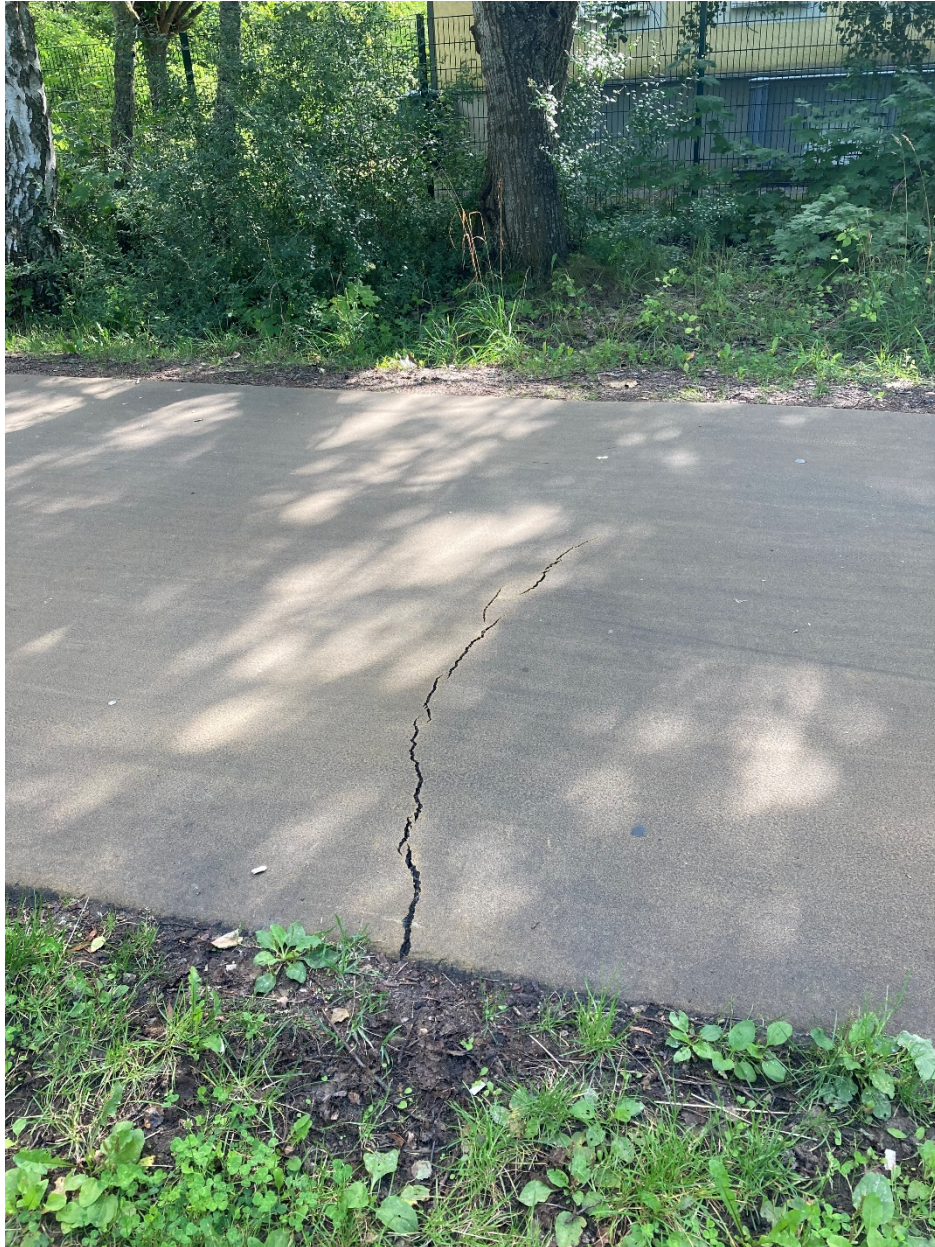
Bild: Riss durch Wurzelwachstum der Weide, August 2023.
