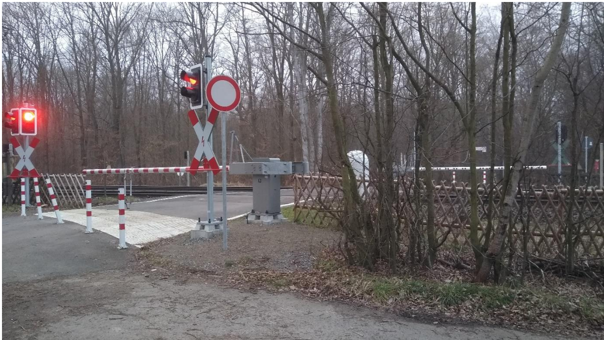
Abbildung 9: Bahnübergang mit ergänzendem Zaum, um Fehlverhalten, wie das Umlaufen des gesperrten Bahnübergangs zu unterbinden; hier Bahnübergang Buchhorst bei Braunschweig (Foto: IfEV)
