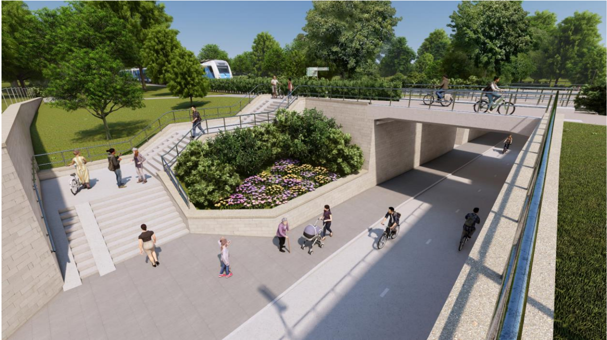
Abb. 5: 3D-Visualisierung von der Grünwaldstraße mit Blick in Richtung Norden auf die Treppe zum Ringgleisweg und die Geh- und Radwegunterführung sowie die Brücke vom Ringgleisweg und den Eisenbahnbrücken (Verbesserungsvorschlag zur Variante 1 mit Rampe als Verbindung zum Ringgleisweg)
