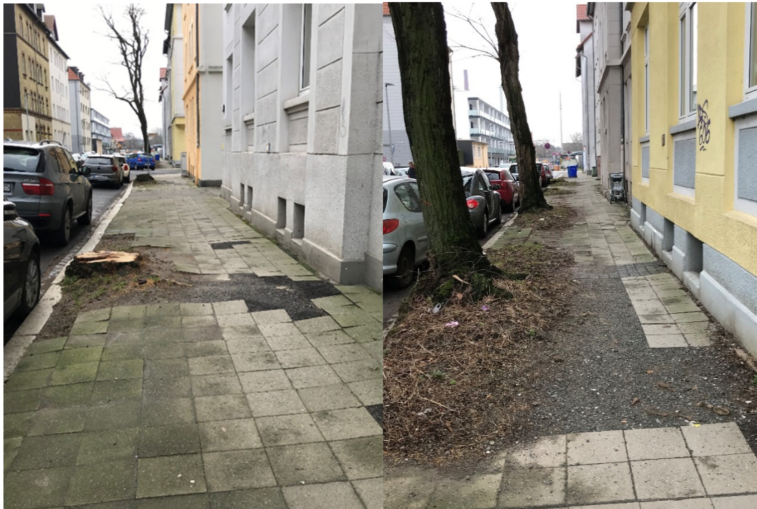
Abbildungen: Schäden in der Eichthalstraße durch Bäume in zu kleinen Altbestandsbaumscheiben.
