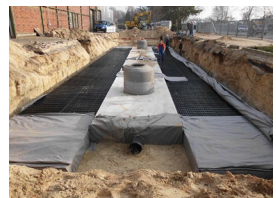
Rigolen zur Regenrückhaltung
