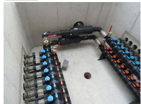
Verteiler Geothermie
