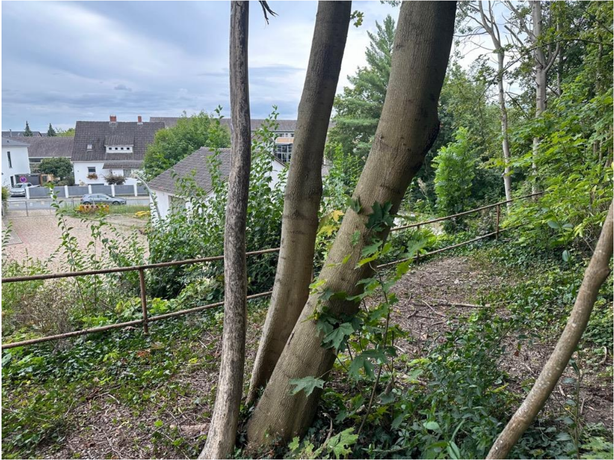
Abgesackte Geländer an der Südseite zum Gelände Bruchweg 4 / 4A
