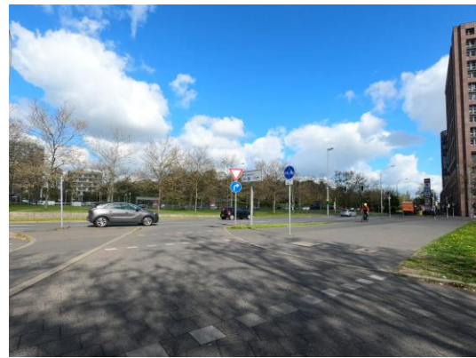
Abbildung 24: Beispiele notwendiger Maßnahmen an Furten aufgrund fehlender Piktogramme und Richtungspfeilen
