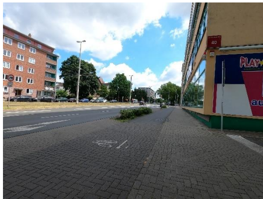
Abbildung 24: Beispiele notwendiger Maßnahmen an Furten aufgrund fehlender Piktogramme und Richtungspfeilen
