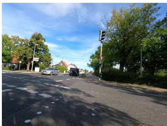
Metallplatten entsprechen nicht den Anforderungen der StVO und RMS
