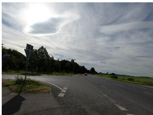
Stark abgefahrne Furtmarkierungen
