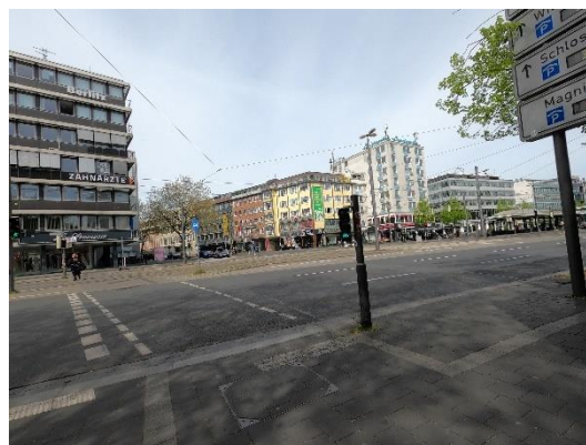
Breite der Markierung entspricht der einer Fußverkehrsfurt und nicht einer Radwegefurt
