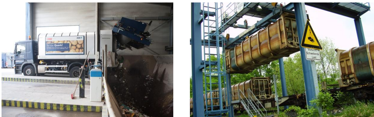
Abbildung 5: Fotos der Restabfallumschlaganlage in Watenbüttel
