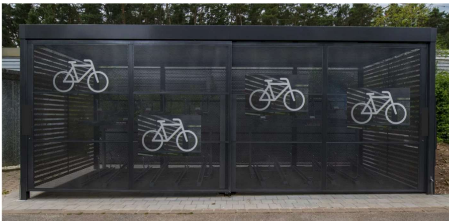
Beispiel einer Lochblech-Bekleidung zur Rückseite zum Parkplatz mit Schildern der B+R Offensive
