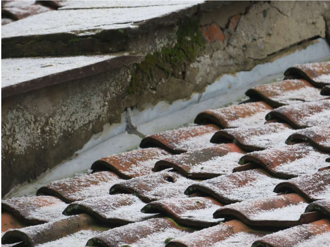
Putzschäden Brandmauer
