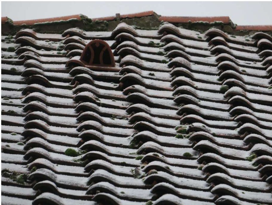
Gemörtelter First und Lüftungsziegel
