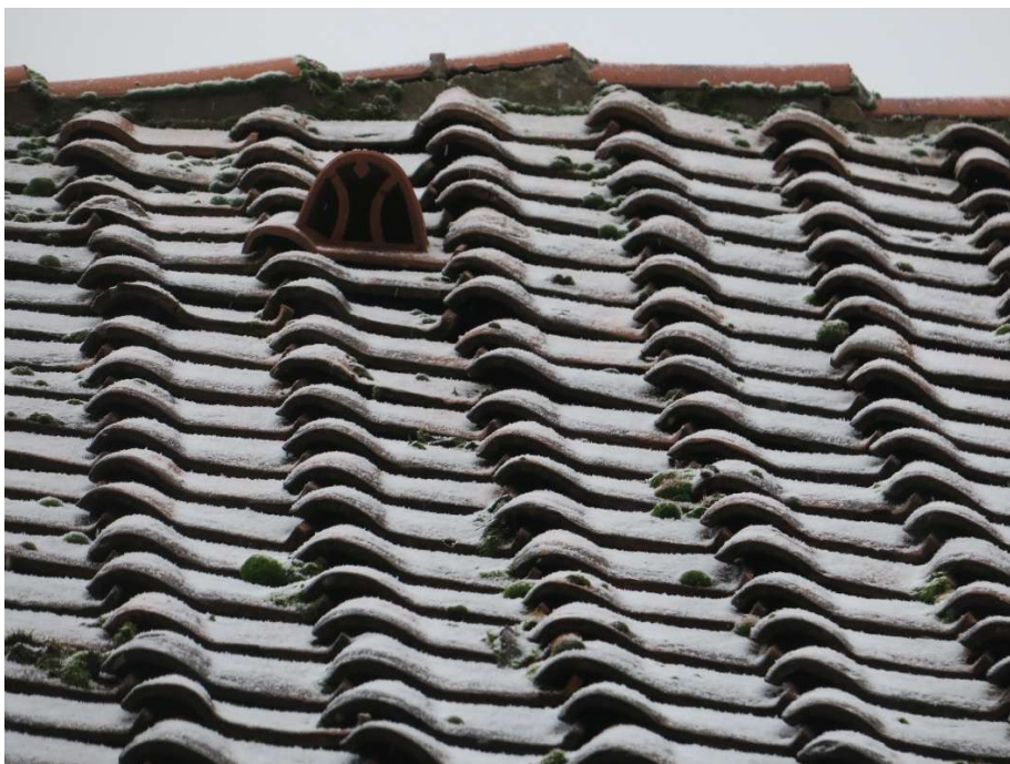
Gemörtelter First und Lüftungsziegel
