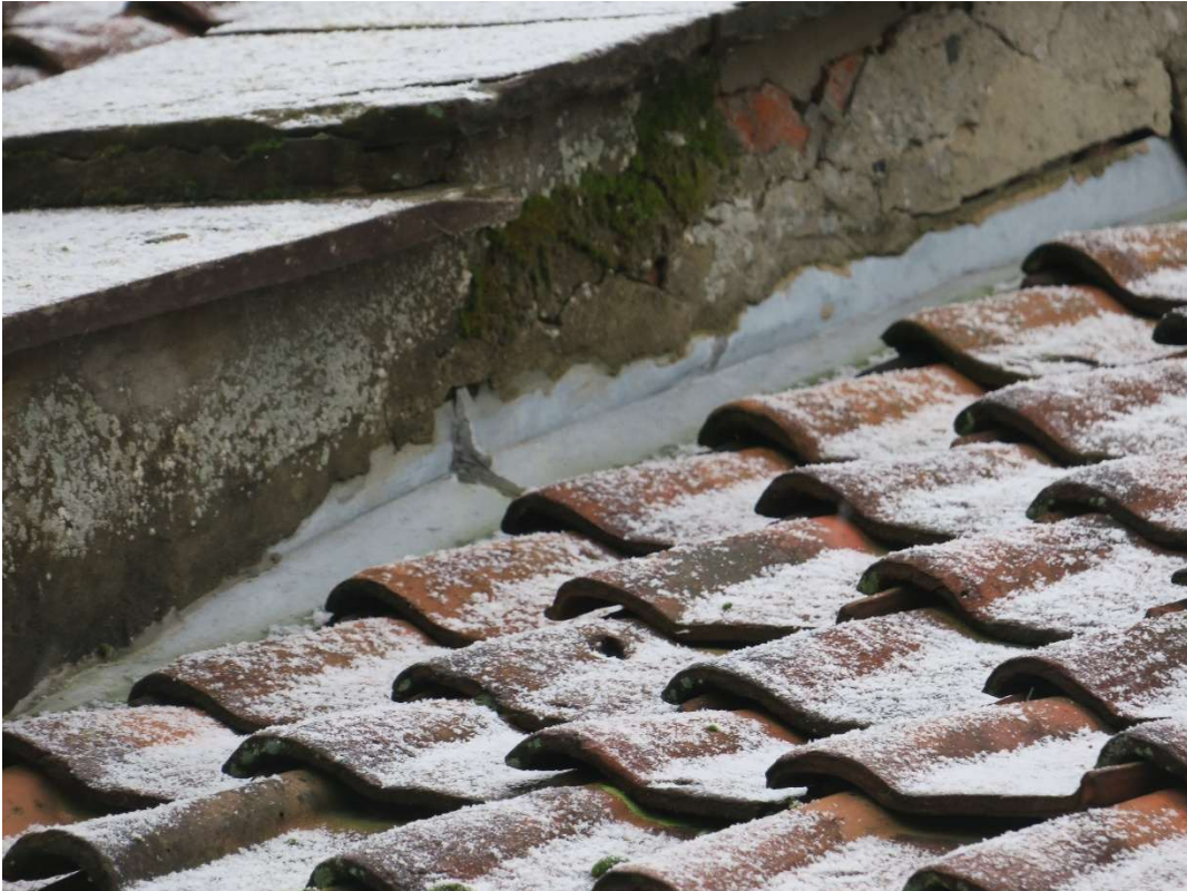
Putzschäden Brandmauer
