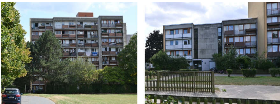
Abbildung 44: Unsanierete Gebäude Regaweg 1-5
