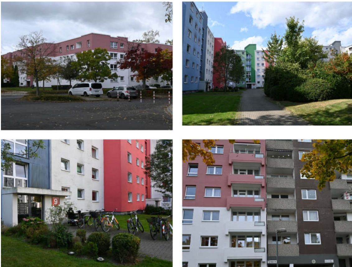
Abbildung 36: Sanierter Gebäudebestand im zentralen Quartiersbereich des Emsviertels
