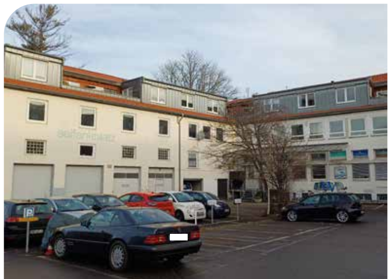
Abb. 104: Parkplatz im Hagenhof
