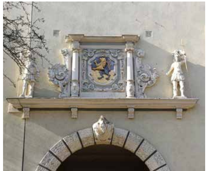
Abb. 69: Portal in der Reichsstraße
