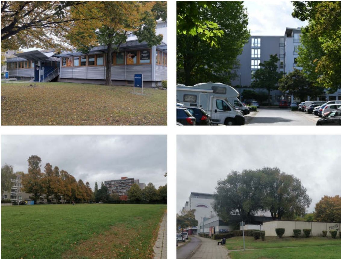
Abbildung 43: Mieterbüro LEG, Seniorenresidenz, Wiesenfläche, Garagen und leerstehendes Parkhaus
