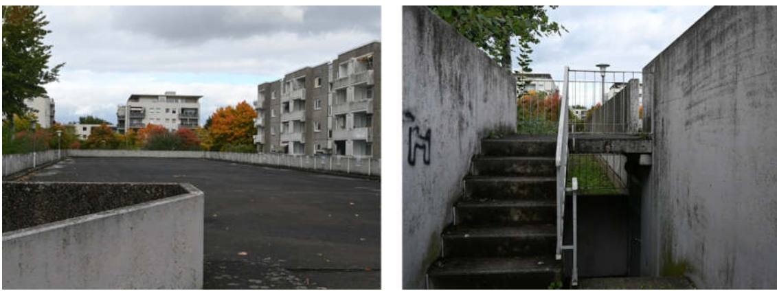
Abbildung 38: Teilweise leerstehende Parkpalette an der Emsstraße
