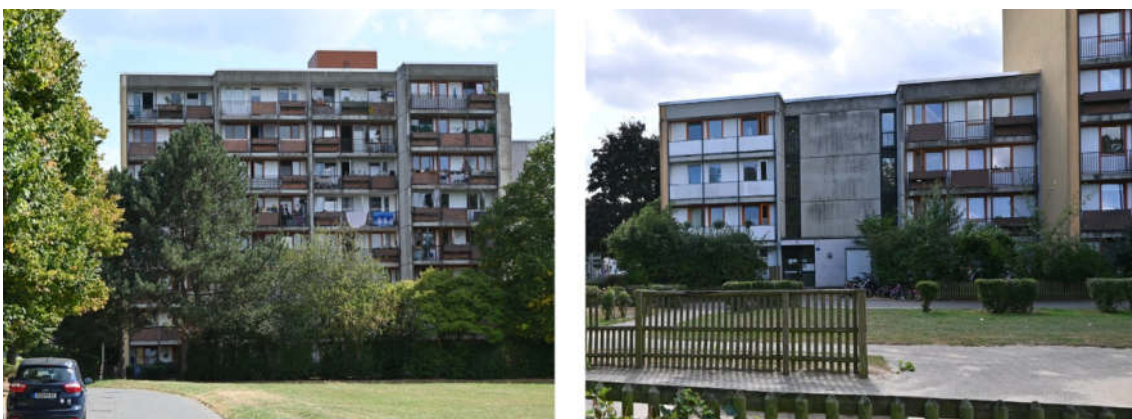
Abbildung 44: Unsanierete Gebäude Regaweg 1-5
