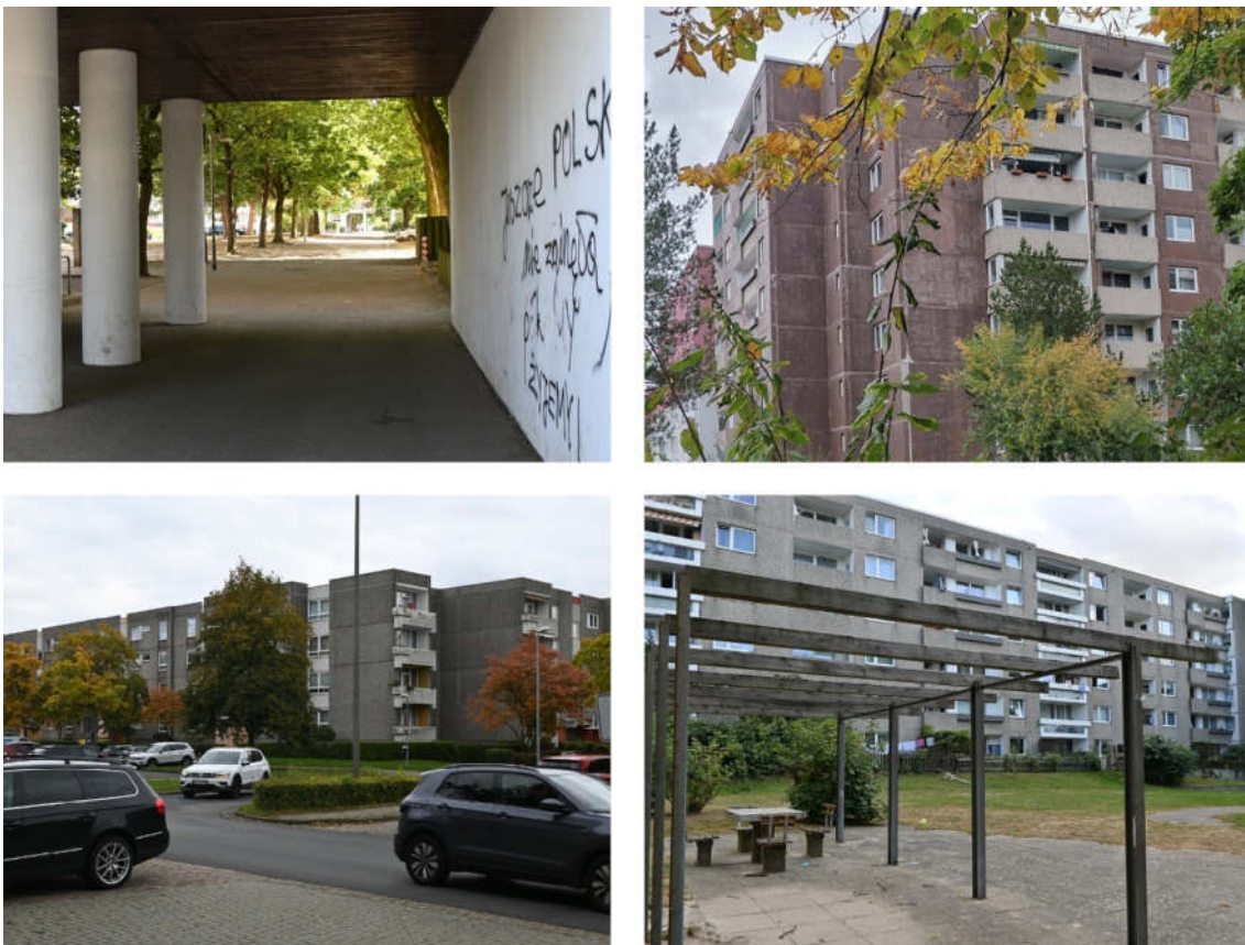
Abbildung 35: Unsaniertes Gebäudebestand im zentralen Quartiersbereich des Emsviertels
