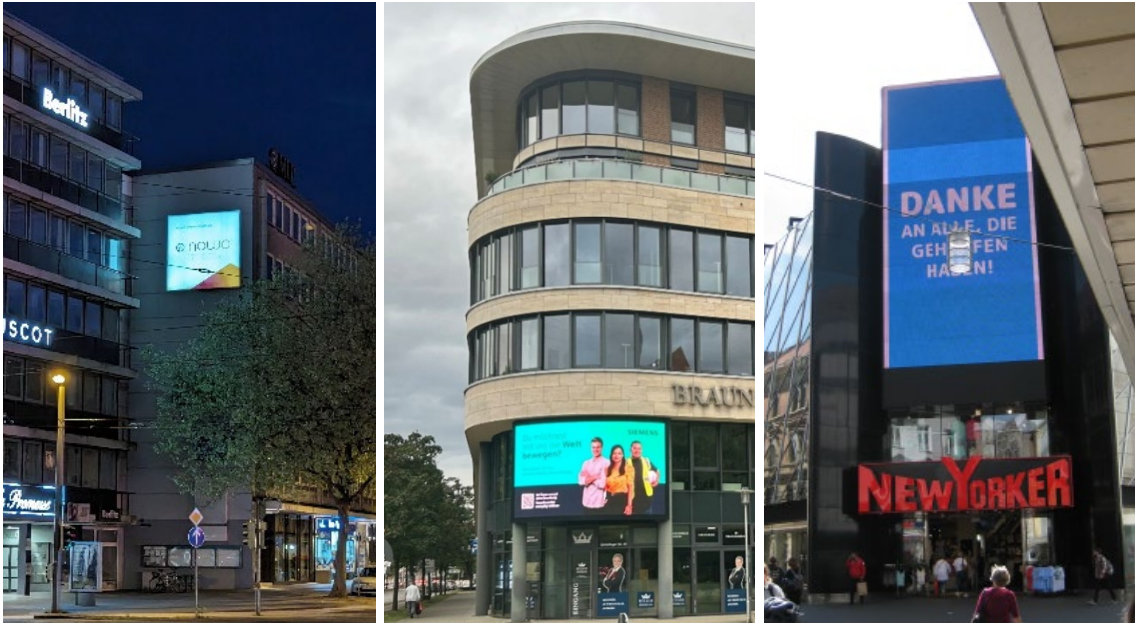
Abbildung 7: Digitale Werbeanlagen an Fassaden in der Braunschweiger Innenstadt (Stadt Braunschweig, 2024)
