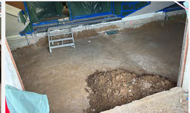
Sohlabsenkung E2 unter Foyertreppen
