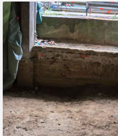
Sohlabsenkung E2 unter Foyertreppen
