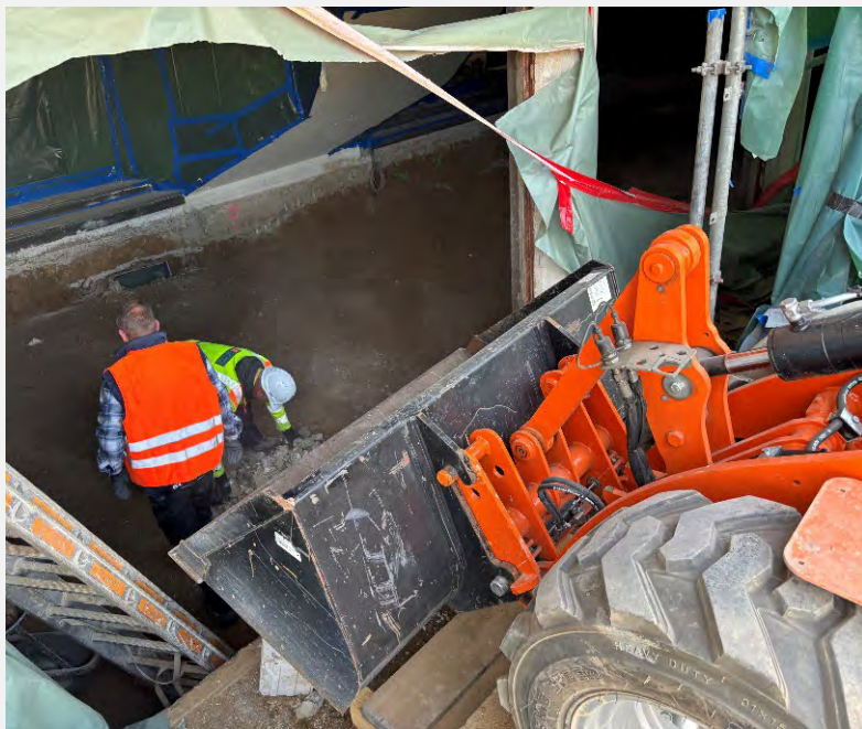
Sohlabsenkung E2 unter Foyertreppen
