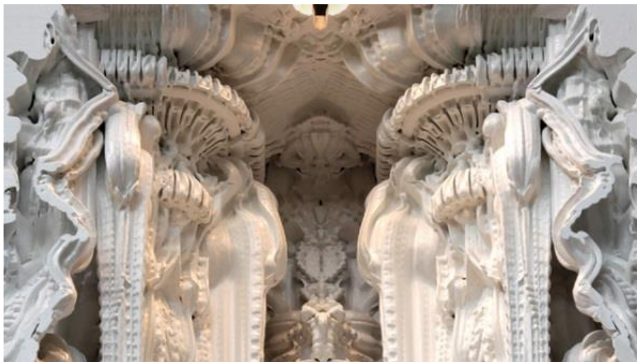
Wandstruktur mittels 3D-Drucker gefertigt
