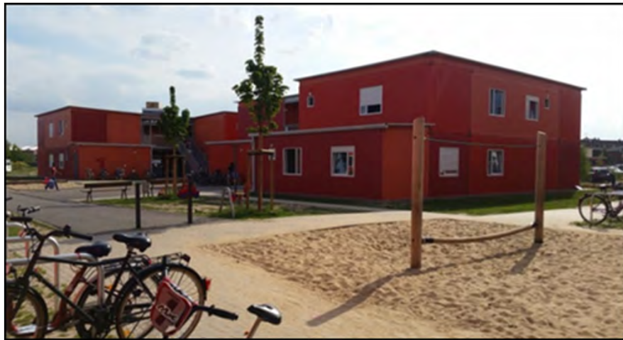
Beispiel für Systembauweise in Bremen
