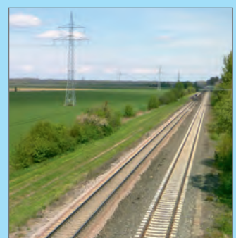
Eisenbahnstrecke und 110-kV-Leitung
