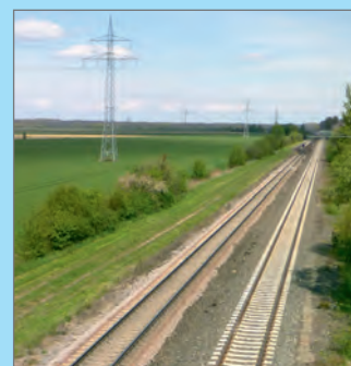
Eisenbahnstrecke und 110-kV-Leitung
