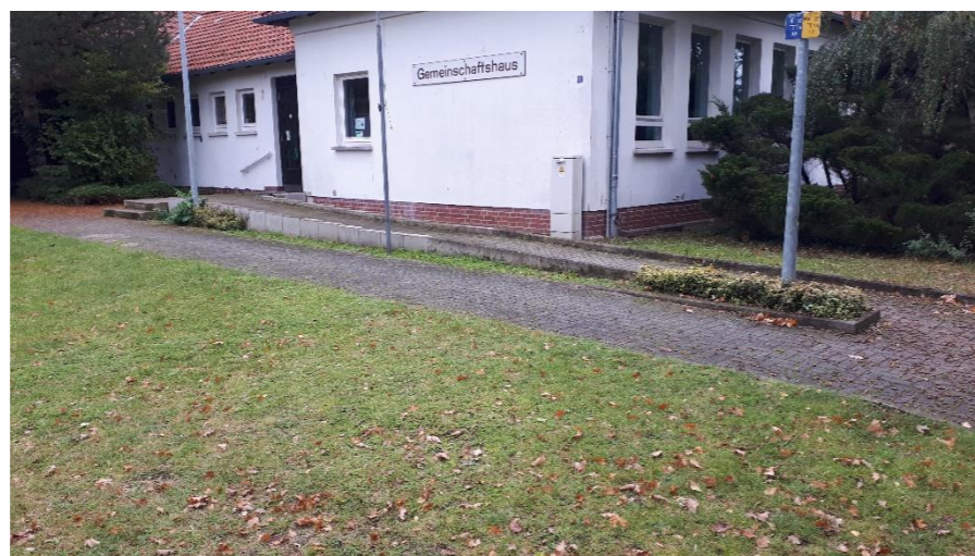
Eichenkamp, Gemeinschaftshaus neu: Bodendecker vor der Rampe
