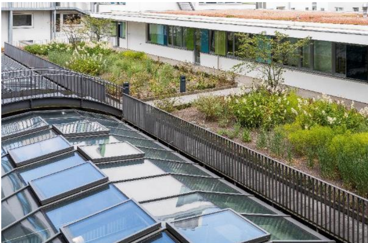
Intensive und Extensive Dachbegrünung des Schlosscarrees © Stadt Braunschweig
