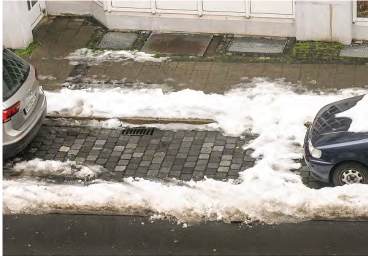
Ein Gully in der Straße Ölshlägern. Die Stadtverwaltung bittet die BürgerInnen um Mithilfe bei der Schneeräumung, weil ihr teurer Vertragspartner ALBA das nicht kann. Foto: Klaus Knodt
