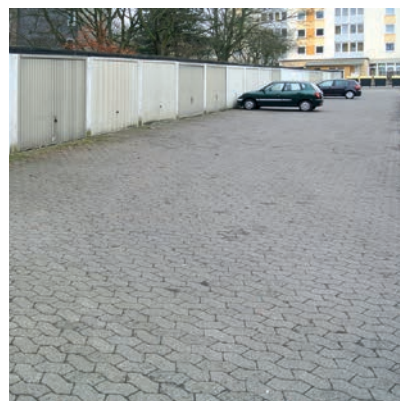
Ergänzung zur Abb. 72, Seite 152: Abbruch Garagen Am Queckenberg
