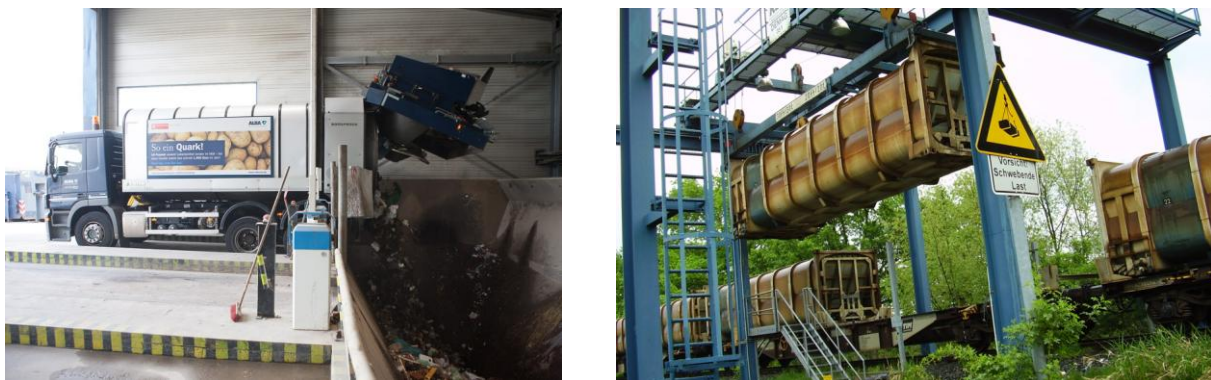
Abbildung 5: Fotos der Restabfallumschlaganlage in Watenbüttel
