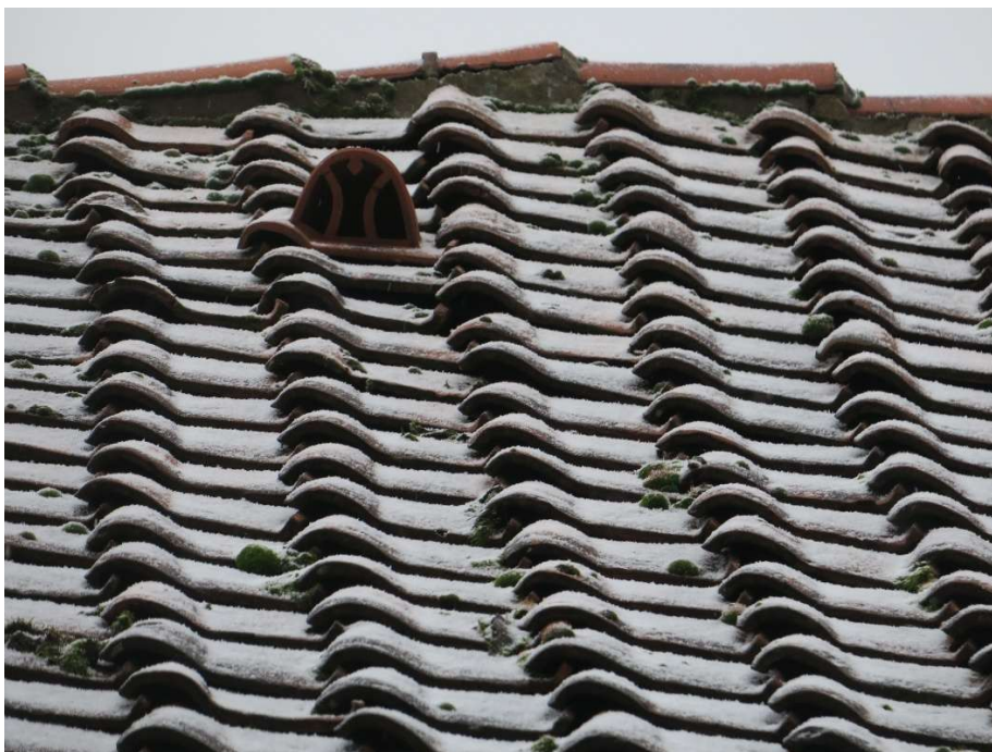
Gemörtelter First und Lüftungziegel
