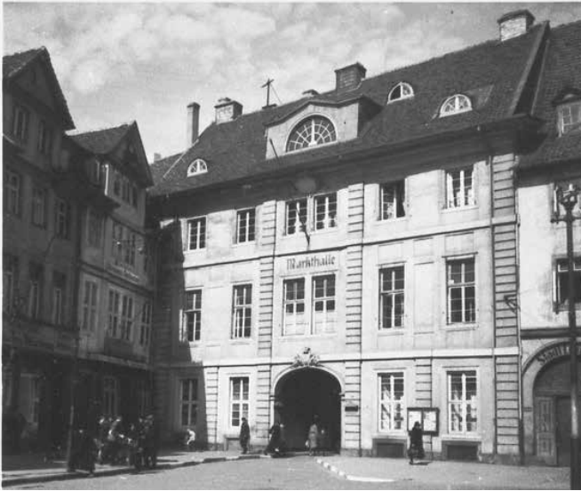
Abb. 15: Zugang zur Markthalle vom Hagenmarkt 1942
