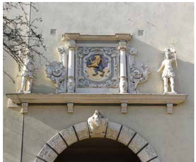
Abb. 69: Portal in der Reichsstraße
